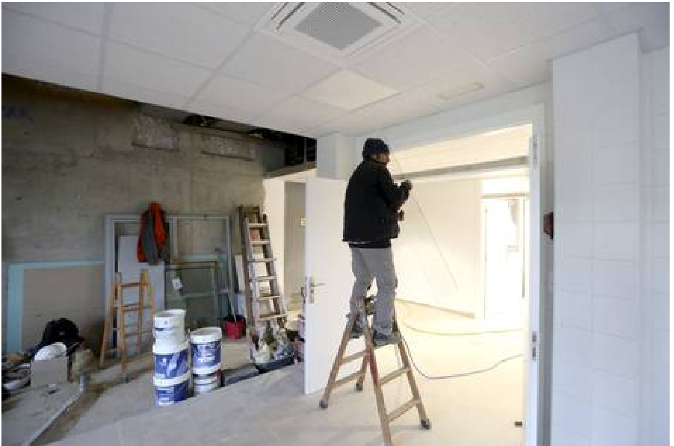
Las obras de construcción de los laboratorios están a punto de terminar. Después se equiparán. | Rafael Gbantes
