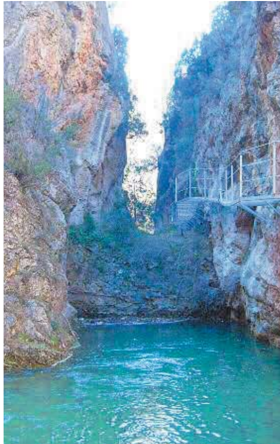
La antigua presa del Arquillo en su estado actual
