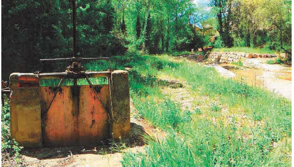
El azud de San Blas en el Molino Viejo en su estado actual tras haber sido retirado parte y hacerse una escollera. A la izquierda, las derivaciones de agua preservadas
