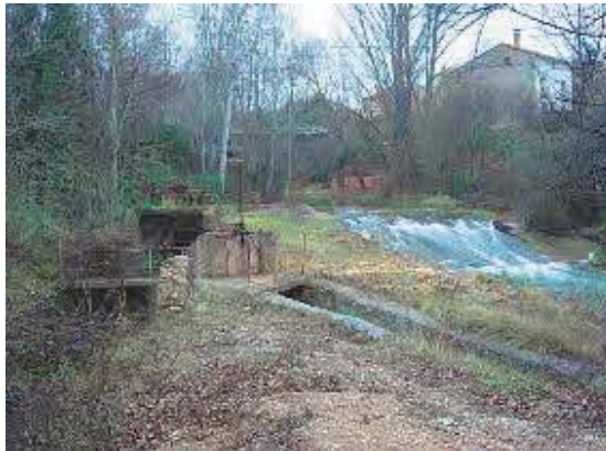
El azud donde el Molino Viejo antes de la intervención de la CHJ
