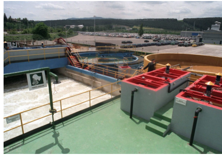
Además de en los ríos se han recogido muestras en las entradas y salidas de varias depuradoras. EFE/Jesús Diges
