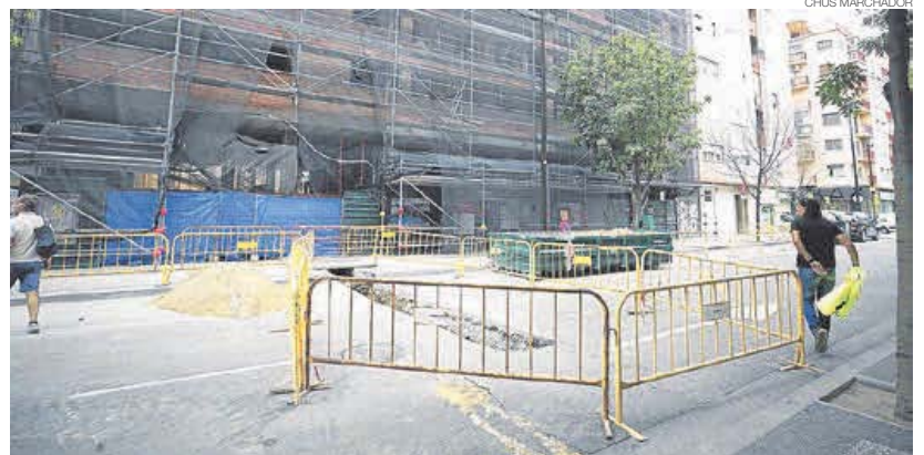
Obras que se están desarrollando en la calzada y que provocaron el corte de luz en el Arrabal, ayer.
