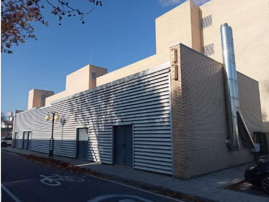
Imagen 3.- Cajas nido de gorrión común instaladas sobre el edificio anexo del Hospital Veterinario. Facultad de Veterinaria.
