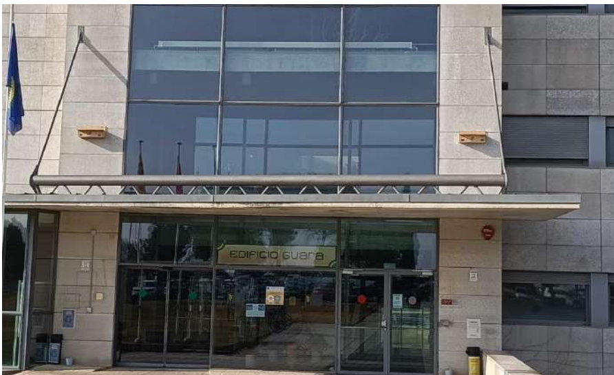
Imagen 4.- Cajas nido de vencejo colocadas sobre la entrada de acceso al edificio de la Universidad Politécnica de Huesca.
